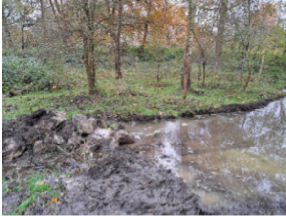
Afgewerkt uitwateringspunt van de waterleiding (links) en aanleg van ondiepe gracht in de infiltratiezone.
