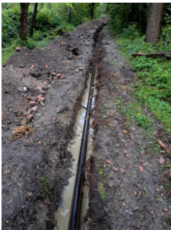
Waterleiding aangebracht in de sleuf (links) en leiding die die onder de oude spoorweg wordt aangebracht (rechts).
