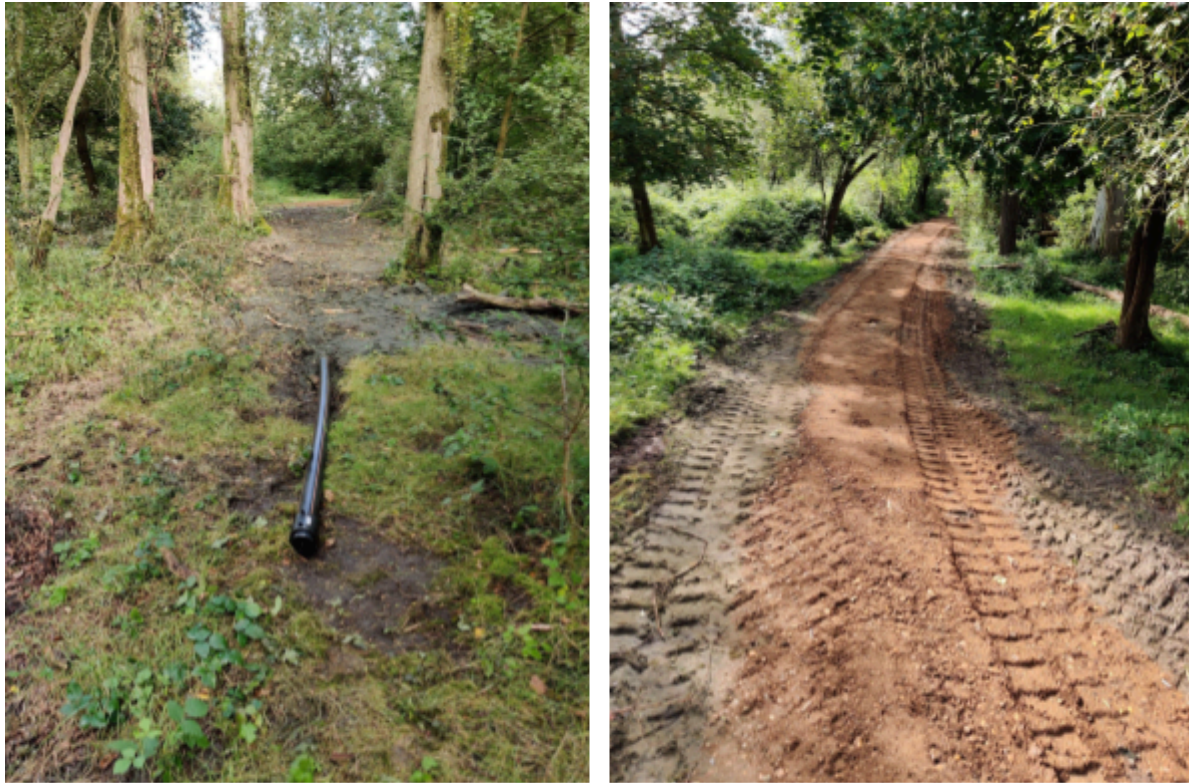
Uitwateringspunt na de eerste fase van de werkzaamheden (links) en met boskiezel hersteld wandelpad na het ingraven van de waterleiding (rechts).
