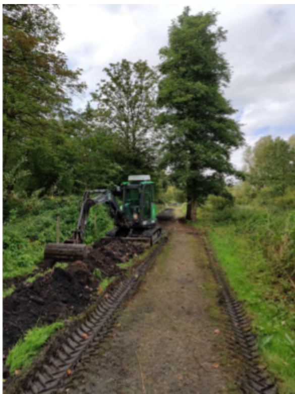
Graven van de sleuf langsheen het wandelpad en gegraven sleuf in het wandelpad met de leiding die klaarligt om in de sleuf te worden gelegd.
