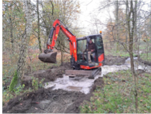
Afgewerkt uitwateringspunt van de waterleiding (links) en aanleg van ondiepe gracht in de infiltratiezone.
