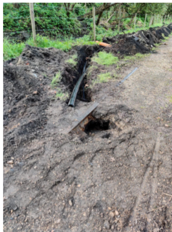
Waterleiding aangebracht in de sleuf (links) en leiding die die onder de oude spoorweg wordt aangebracht (rechts).
