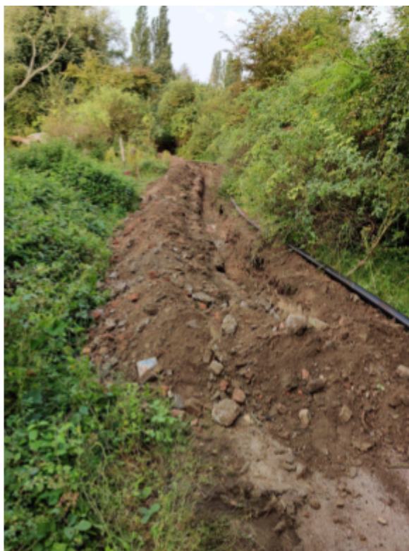
Graven van de sleuf langsheen het wandelpad en gegraven sleuf in het wandelpad met de leiding die klaarligt om in de sleuf te worden gelegd.
