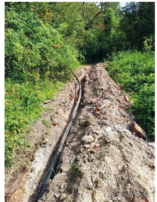
Aanleg buizen - Foto: Danny Jonckheere
